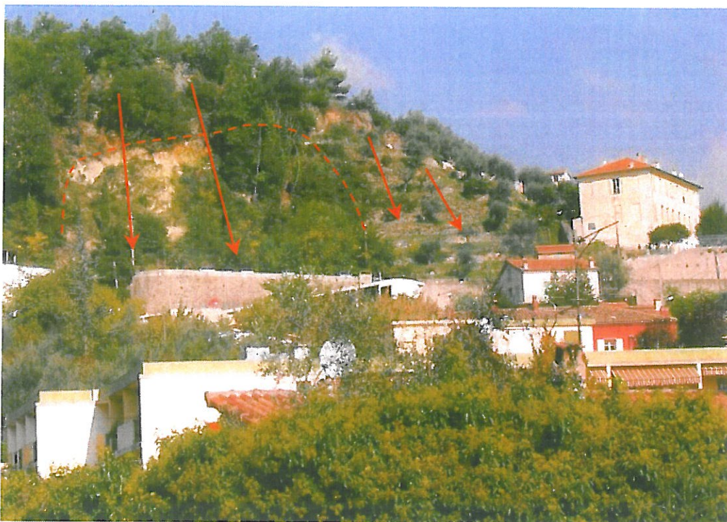
Vue sur la zone de glissement à proximité du village et trajectoire possible de blocs
